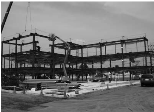
来年春の開設を目指してすすむ建築工事。
